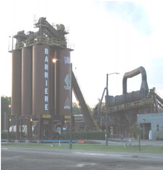
Asphalt Plant, Boutte, LA
